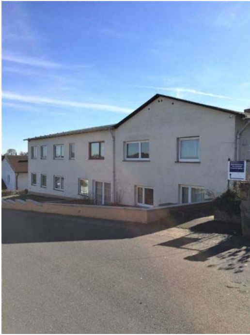
Blick von der Straße
